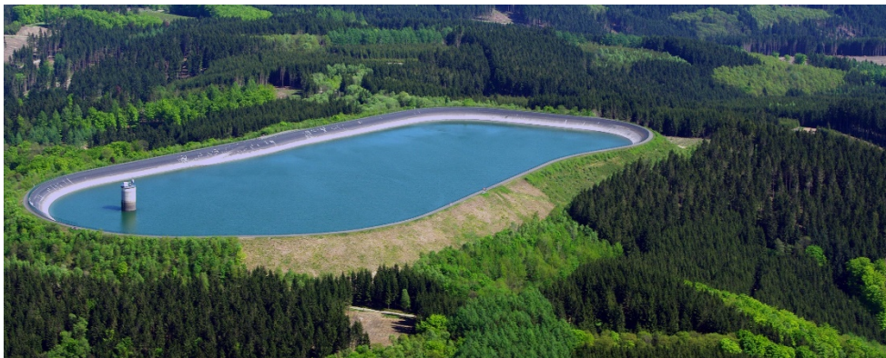
Abbildung 1 - Pumpspeicherkraftwerk Rönkhausen Quelle: Wikimedia, G.Schmitz , CC BY-SA 3.0
